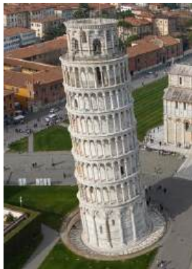
Gambar 1. 1 Menara Pisa yang miring akibat Proses Konsolidasi Tanah belum selesai.
