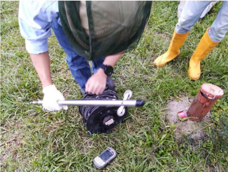
Gambar 6. 4 Proses pemasangan Inclinometer
